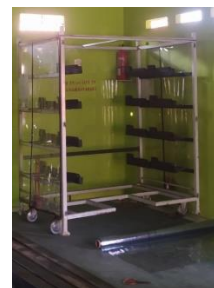
Gambar 26. Proses Pemasangan Mika
