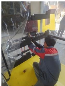
Gambar 24. Proses Pemasangan Tempat Part
