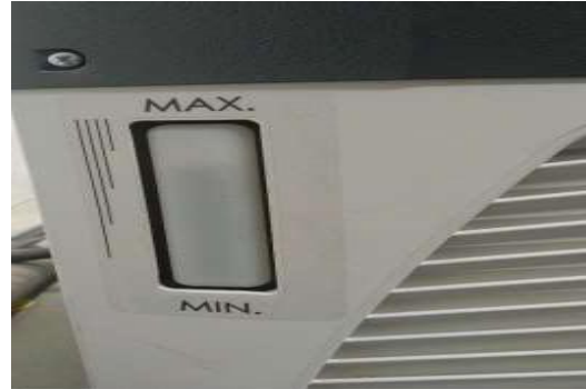
Gambar 3. kaca control ketinggian radiator (Sumber: CV Laksana )
