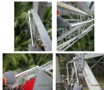
Gambar 7. Pengecekan Torsi / Kekencangan Baut
