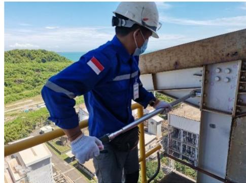
Gambar 3. Pengencangan Baut Tower
