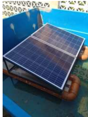
Gambar 7. Ujicoba PLTS terapung pada kolam uji
