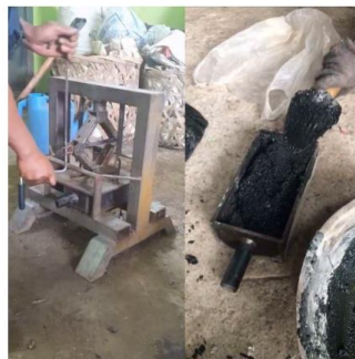
Gambar-2. Proses pencetakan dan pemadatan paving block
