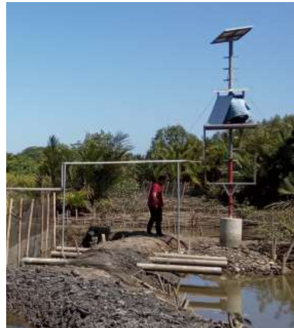
Gambar 6. Pemasangan panel surya dan sistem aerasi.
