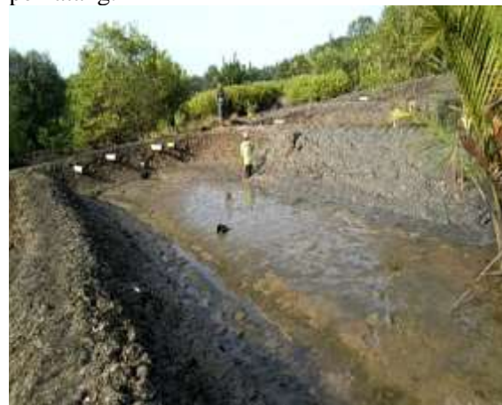
Gambar 2. Perbaikan tanggul/pematang
