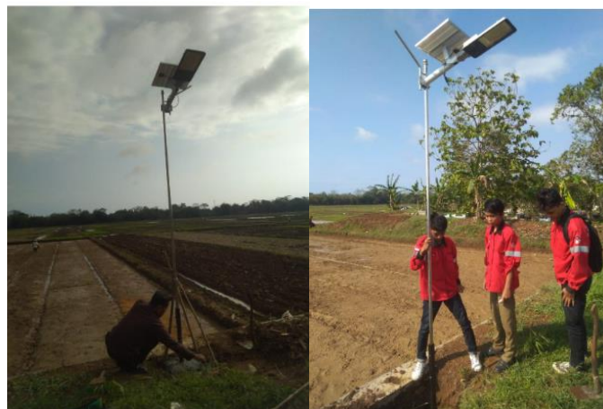
Gambar 9. Proses Pemasangan Tiang Lampu Penerangan di Jalan Persimpanagn Desa Banjarwaru
