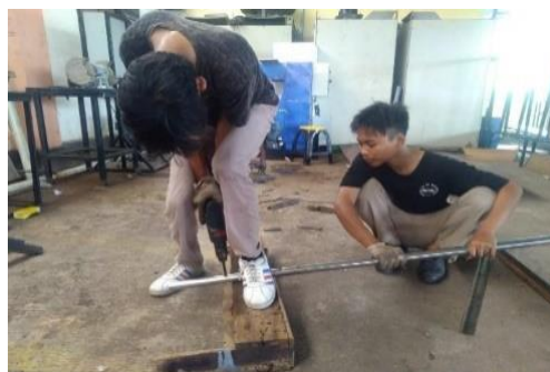
Gambar 7. Proses Pembuatan Lubang Pada Tiang Lampu
